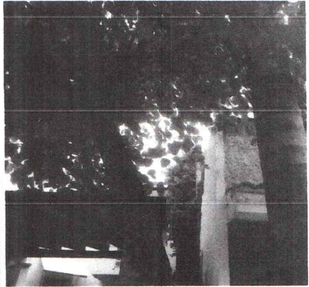
Foto 4. Vista lateral del árbol de Pata de Vaca, especie arborea que presenta bretaduras en su tronco base y comprende de una inclinación pronunciada hacia la vía pública, el cual se encuentra sostenida a la Palma Real por medio de una cuerda.
